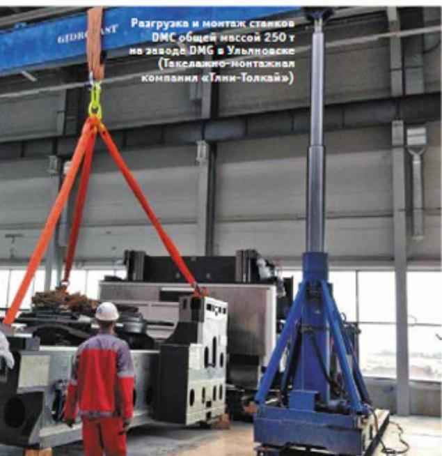
Разгрузка и монтаж станков DMC общей массой 250 т на заводе DMG в Ульяновске (Такелажно-монтажная компания «Тлии-Толкай»)
